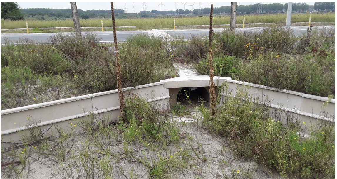
Rugstreeppadtunnel onder Kwarikweg, tussen Groot Rietveld en Rietveld Kallo
